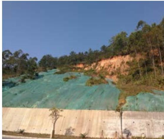
照片 8 环市东路西侧、碧桂园山语对面（滑坡、有马刀树现象-坡向 130°，坡高 45m，坡长 60m）
