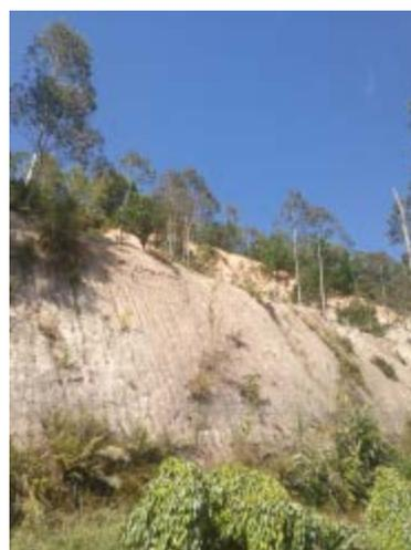
照片 18 高墩(坡底水蚀现象, 有掉块剥落-坡向 156°, 坡高 35m)
